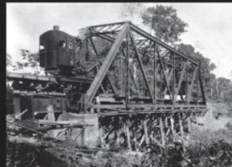
Guindaste de obras a vapor, usado em construção de ponte com pesada estrutura de ferro, sobre um afluente do rio Madeira
